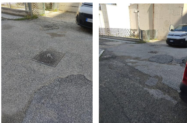
Foto 2 e 3 - Pozzetto di raccolta acque di scarico in pubblica fognatura
