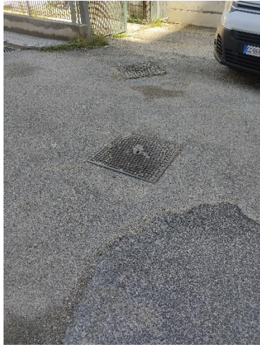
Foto 2 e 3 - Pozzetto di raccolta acque di scarico in pubblica fognatura
