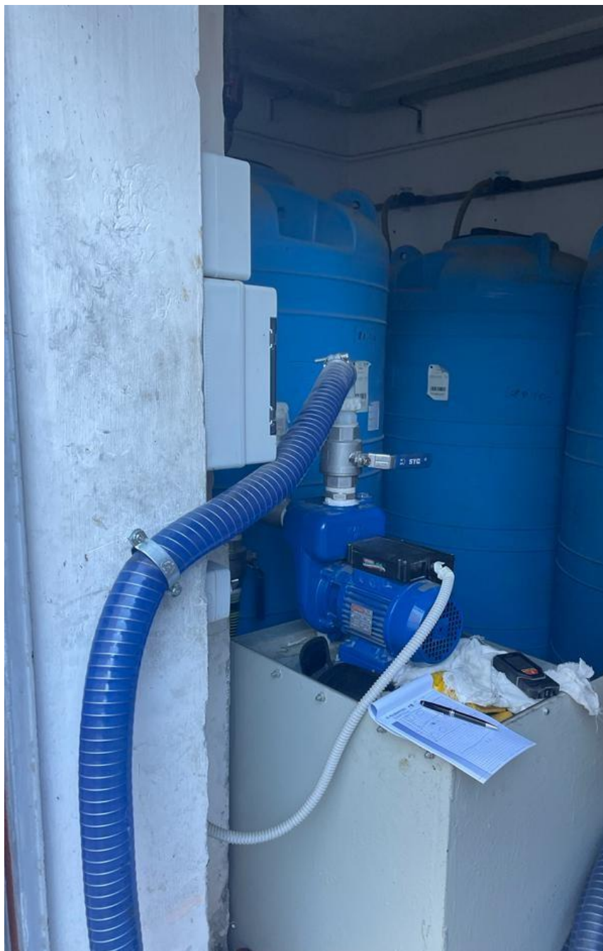
Locale esistente dove posizionare l'impianto di depurazione
